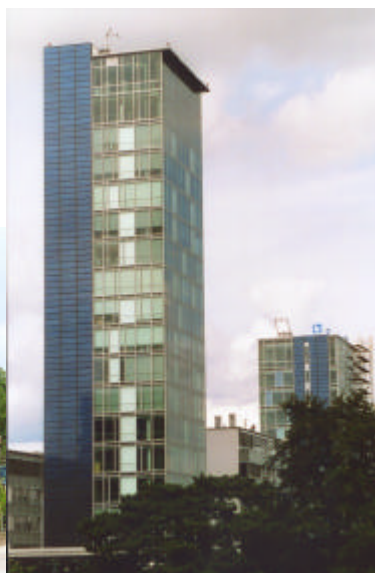
Fig1b Solcellemoduler er benyttet ved renoveringen af kontortårne i Freiburg, Tyskland.
