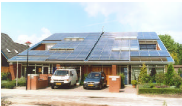
Fig1a Solceller og termiske solfangere dækker hele taget af et nul-energihus i Amersfoort, Holland.
