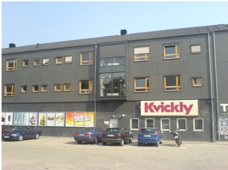
Figur 10. Kvickly-pladsen på Indre Nørrebro, hvor der i forbindelse med Kvarterløftet på Indre Nørrebro blev udviklet et projekt i samarbejde med en privat developer. Projektet havde til formål at omdanne p-pladserne til boliger. (Foto: Pernille Arborg).
